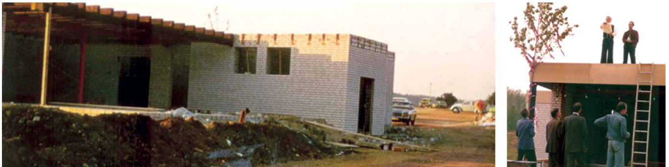
Auf den Bildern ist der Rohbau des Clubhauses und das Richtfest zu sehen, das mit der Gemeinde Frimmersdorf gefeiert wurde.
